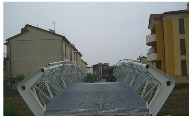
Foto 4 – passerella pedonale, Camisano V.no (VI)
