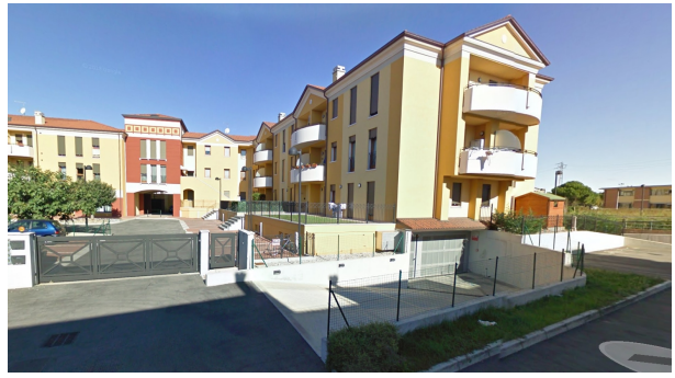
Foto 2 – complesso edilizio residenziale Camisano Vicentino (VI)
