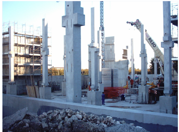
Foto 3 – Cantiere Italconst srl via Pola, Torri di Quartesolo (VI)
