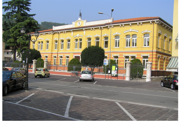
Foto 2 – Biblioteca Com.le, Comune di Chiampo (VI)
